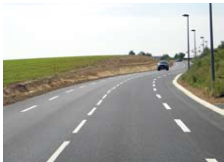
Route de St-Quentin : assainissement, eau potable et voirie
