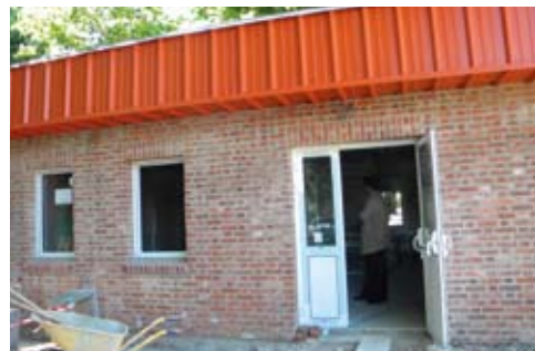
Construction d'un local destiné à l'Osa athlétisme
