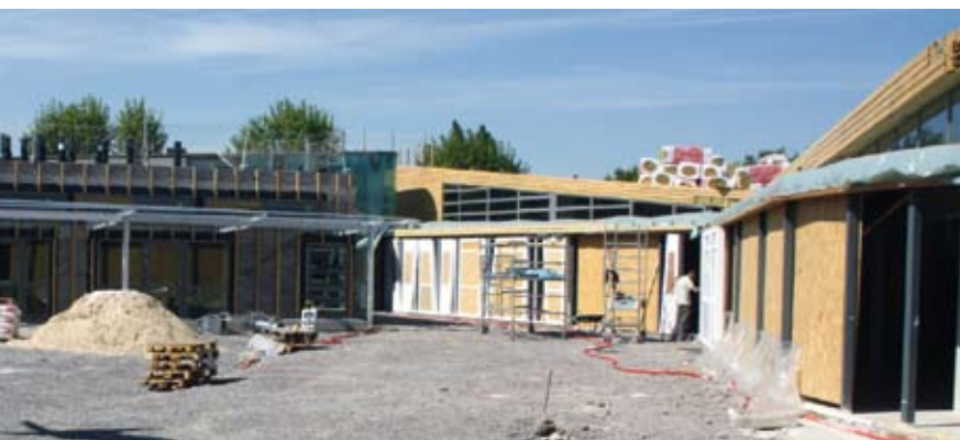
Chantier en cours
