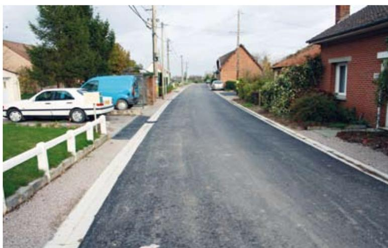
D'importants travaux de voirie ont été réalisés cet été au niveau de la chapelle chemin de Widdebrouck. Le projet consistait à la création d'un réseau d'assainissement pluvial, la pose de caniveaux et de regards grille ainsi que la création de trottoirs revêtus d'un enduit gravillonné. La chaussée a été recalibrée, renforcée et recouverte d'un tapis d'enrobés. Les services techniques ont complété l'aménagement par le remplacement des panneaux de police.
