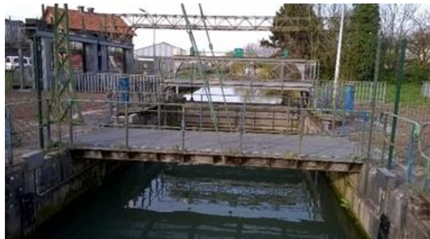
Photo n° 6 : Porte de Garde
