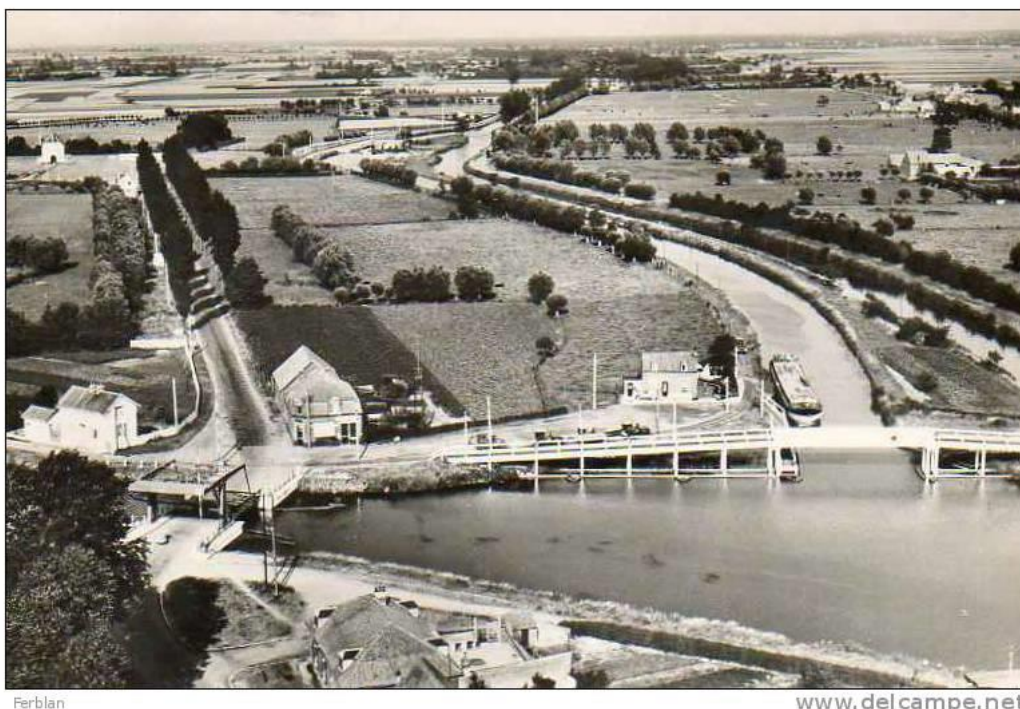
Photo n° 10 : Vue aérienne du bassin des quatre faces
