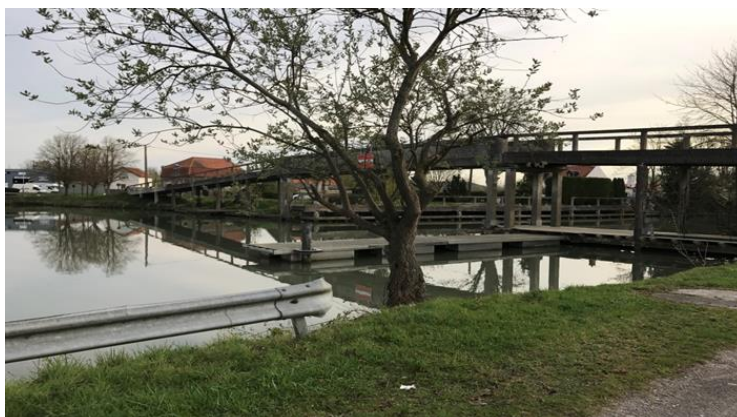
Photo n° 40 : Passerelle béton traversant le bras de la Lys
