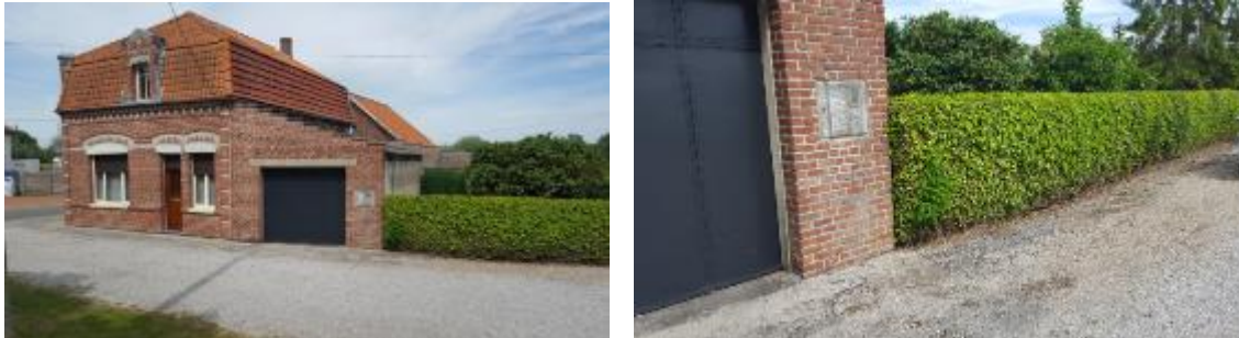
Photo n° 37 : Coffret de coupure électrique de la maison du fort Gassion
