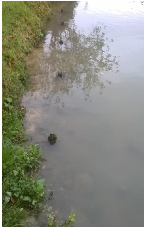
Photo n° 12 : anciens pieux bois et enrochements
