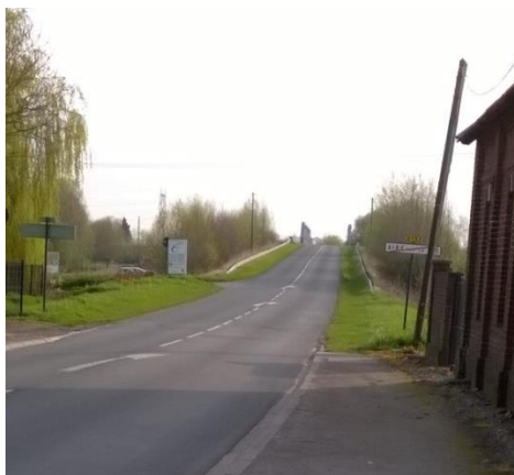
Photo n° 18 : Vue rue du fort Gassion vers le pont
