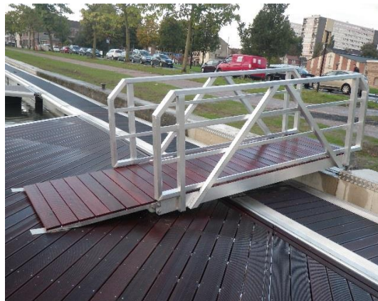
Photo n° 2 : Exemple de passerelle accès ponton
