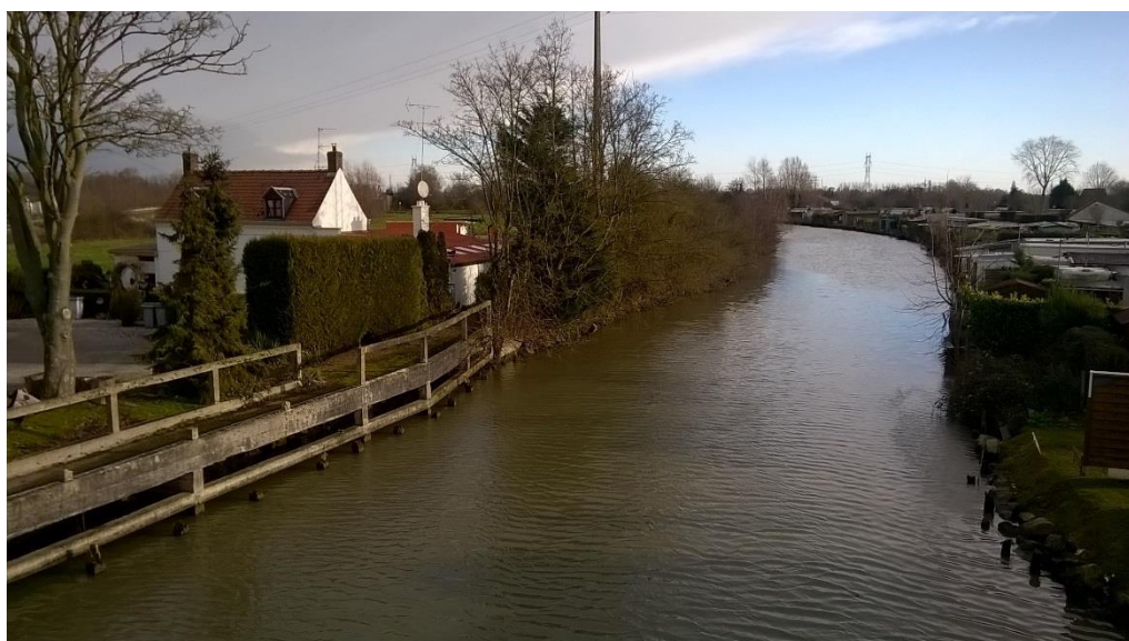
Photo n° 14 : Vue vers l'aval du bras de la Lys
