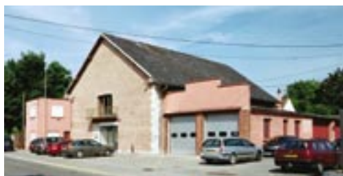
Ancienne caserne des pompiers
