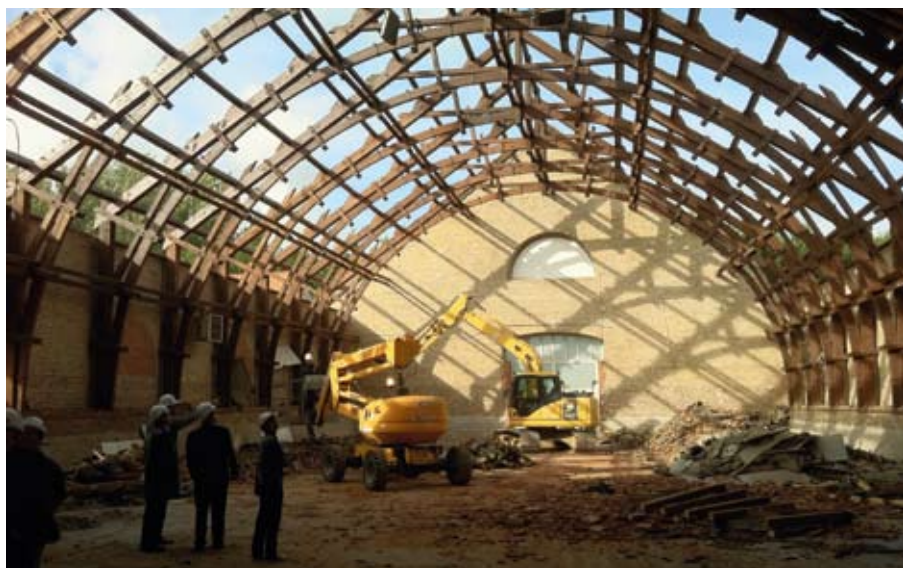
Salle du Manège en travaux
