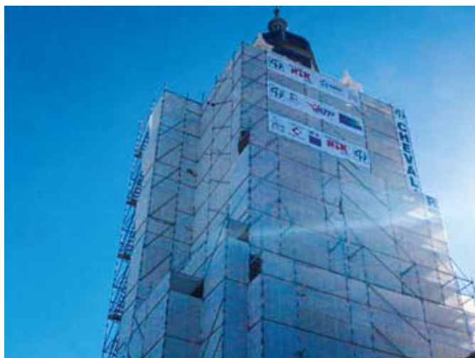
Travaux en cours
