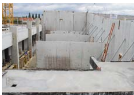
Pose des vestiaires
