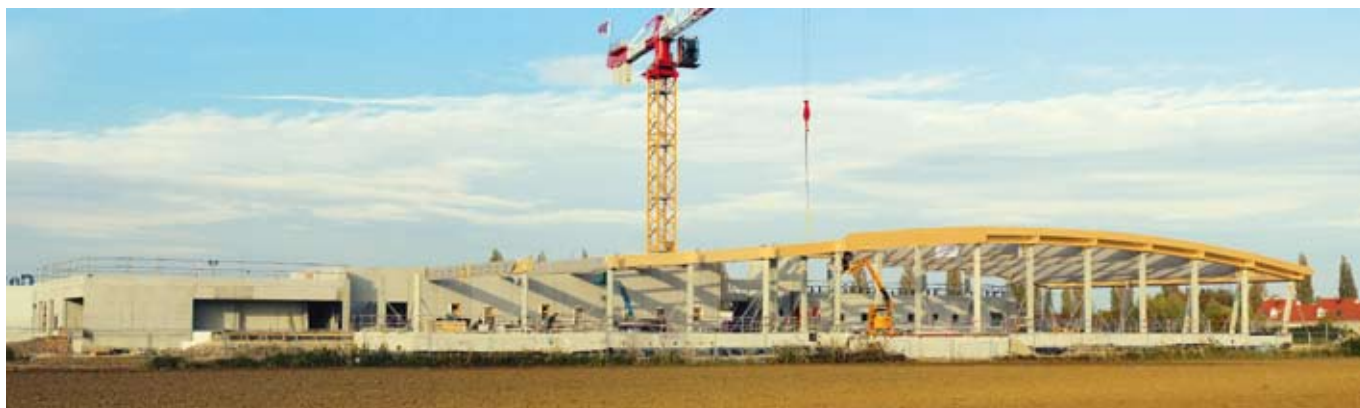
Pose de la couverture
