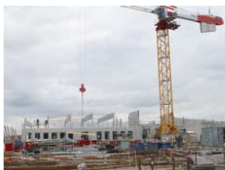
Pose de la charpente
