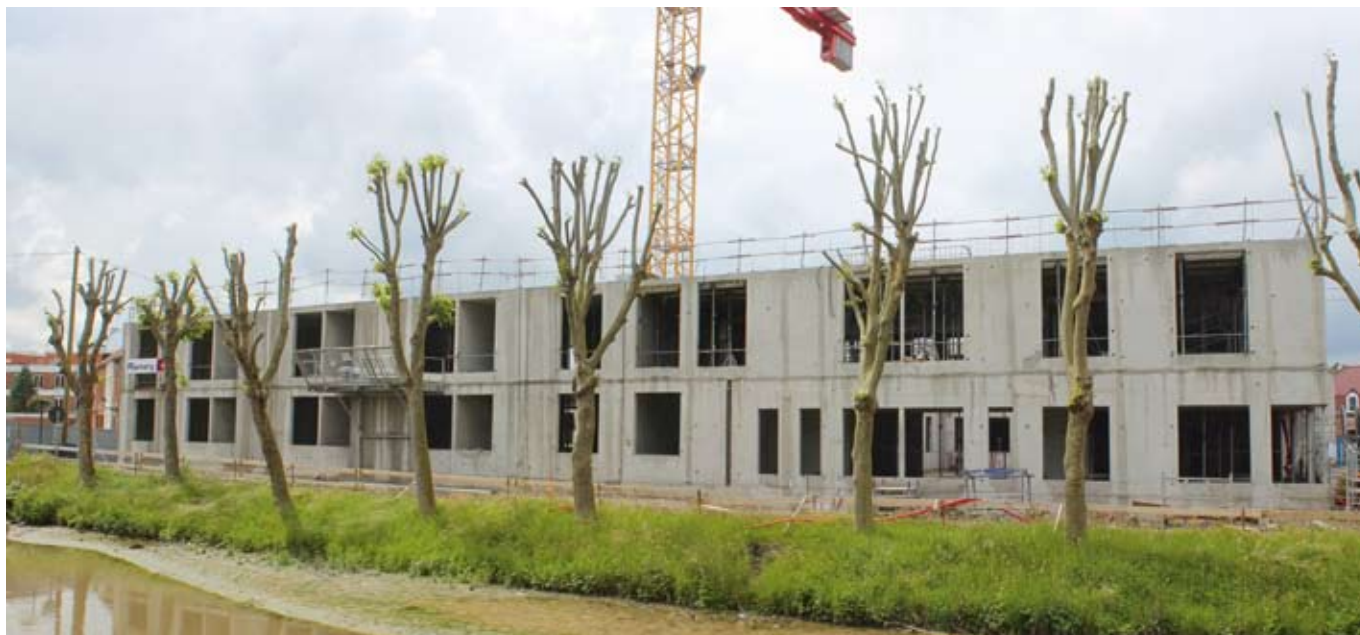
Travaux en cours
