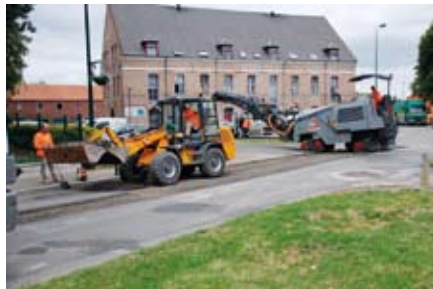
Aménagement de la piste cyclable, boulevard de l'Arsenal
