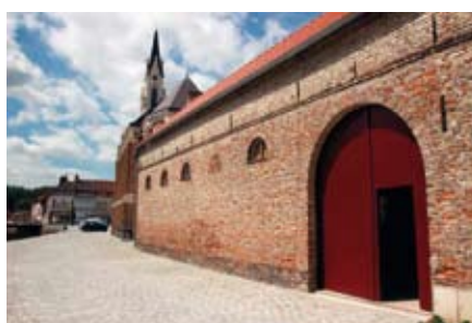
Aménagement d'un local pour stocker les vélos
