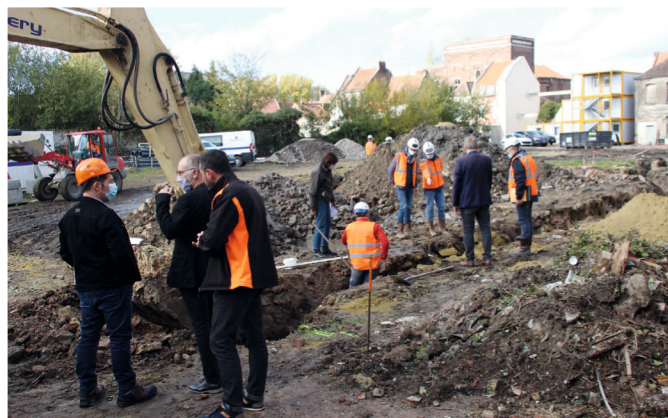
Travaux en cours
