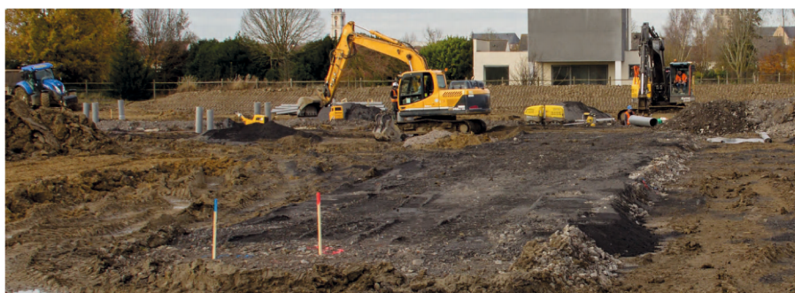
Travaux en cours
