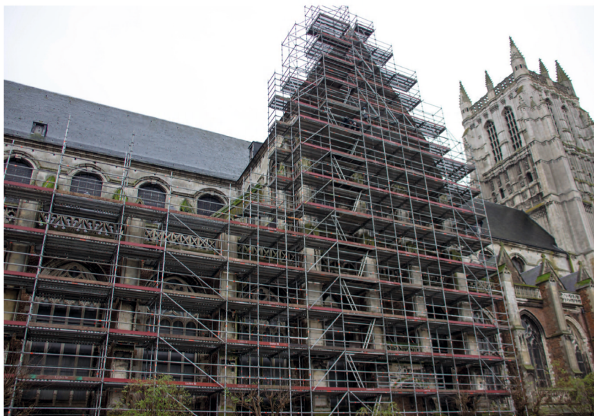
Face nord, travaux en cours
