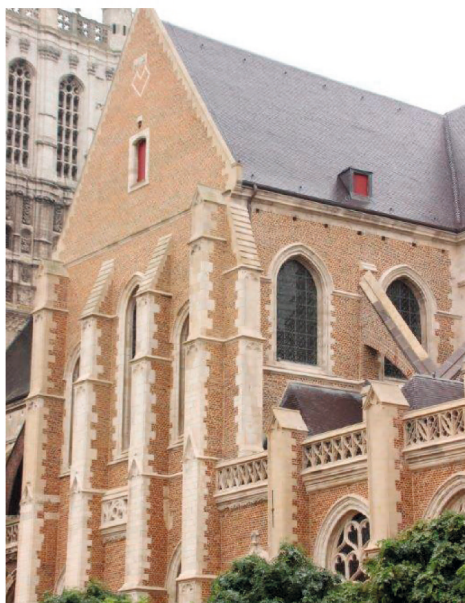
Face sud, travaux terminés
