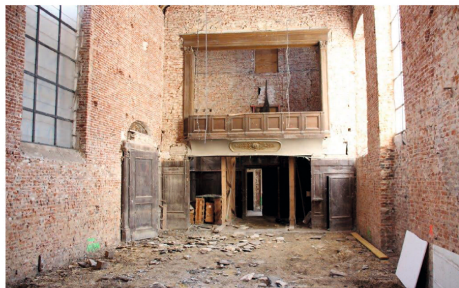
Future médiathèque dans la chapelle
