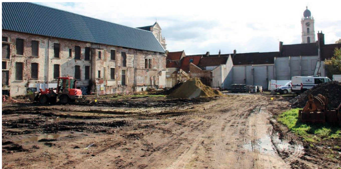
Travaux en cours
