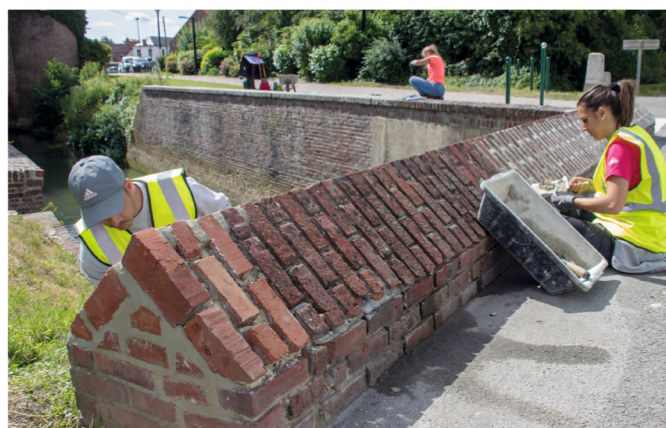
Travaux réalisés par l'APRT
